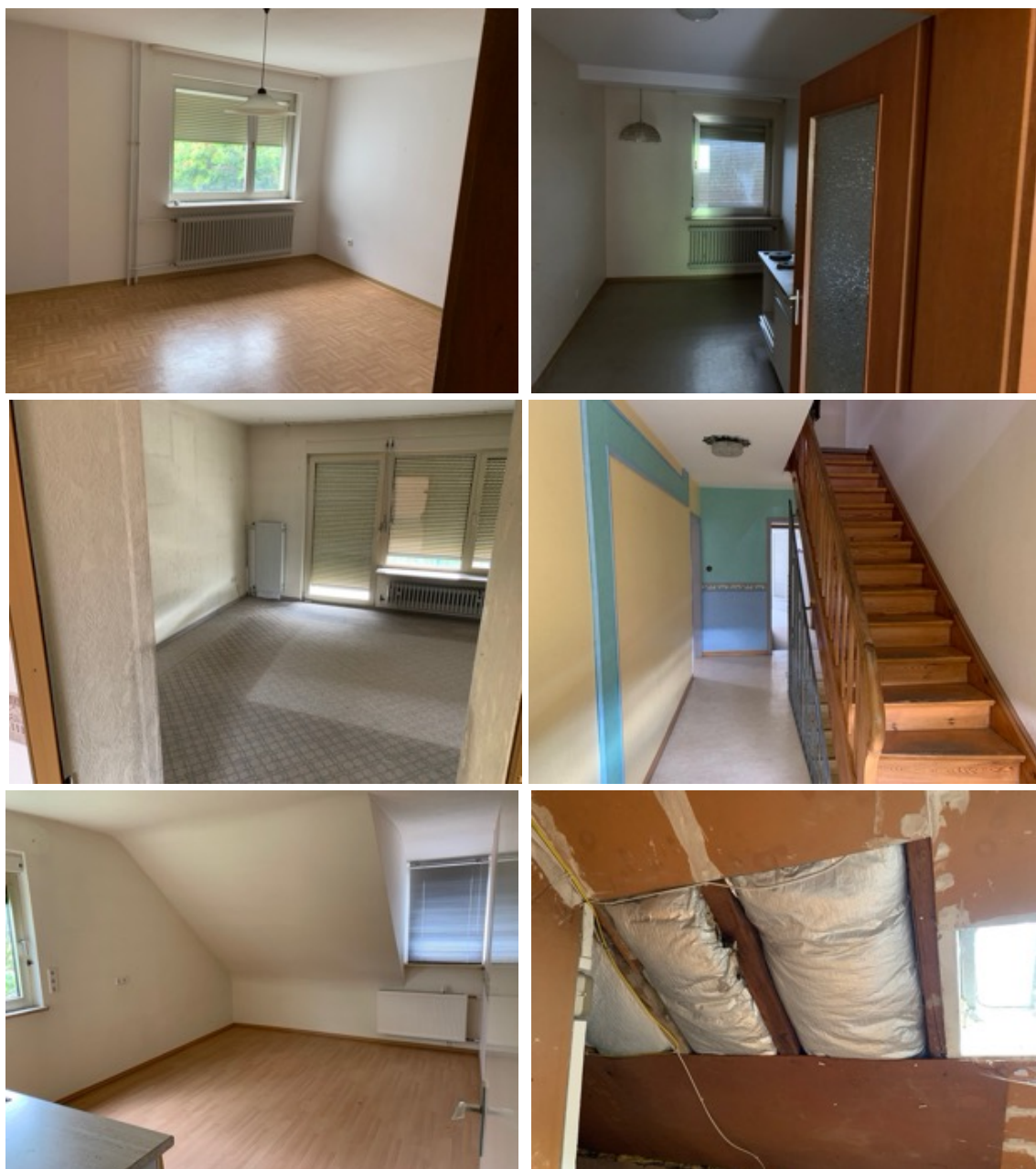
Foto 16: Bauleitplanung „Wohnanlage Alte Gärtnerei“: Bestandserfassung - Innenräume des Wohnhauses - Wohnräume
