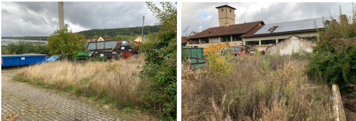
Foto 5: Bauleitplanung „Wohnanlage Alte Gärtnerei“: Bestandserfassung - Brachfläche (Nr. 9 in Abb. 2) und abgebrochenes Gewächshaus (Nr.10 in Abb. 2)
