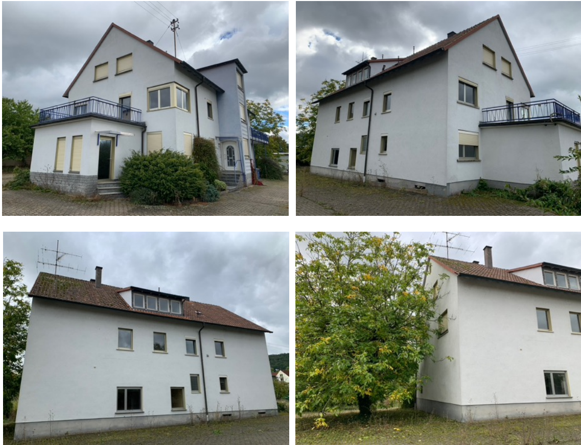
Foto 13: Bauleitplanung „Wohnanlage Alte Gärtnerei“: Bestandserfassung - links oben: Wohnhaus (Nr. 27 in Abb. 2), oben links: SW-Ansicht, Oben rechts: NW-Ansicht, unten links: N-Ansicht, unten rechts: NO-Ansicht
