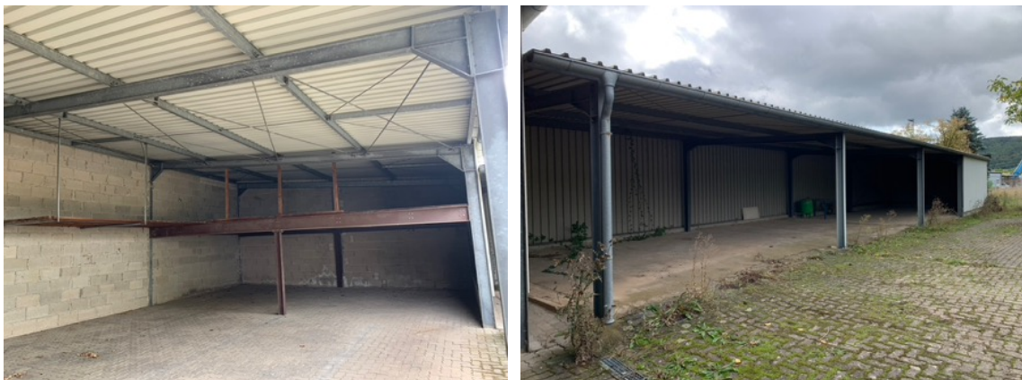
Foto 14: Bauleitplanung „Wohnanlage Alte Gärtnerei“: Bestandserfassung - links oben: Offene Hallen (Nr. 28 in Abb. 2)
