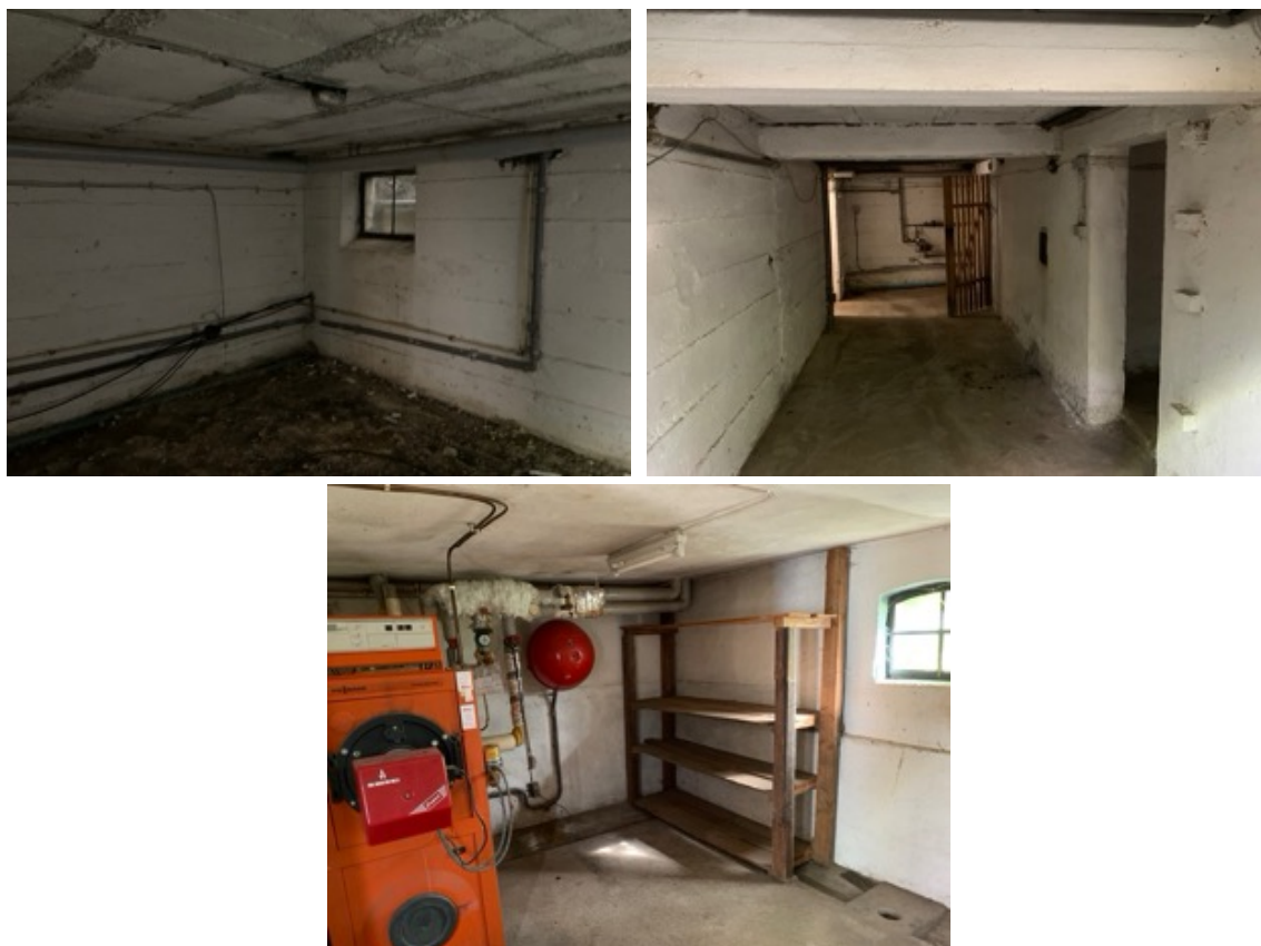
Foto 15: Bauleitplanung „Wohnanlage Alte Gärtnerei“: Bestandserfassung - Innenräume des Wohnhauses - Keller
