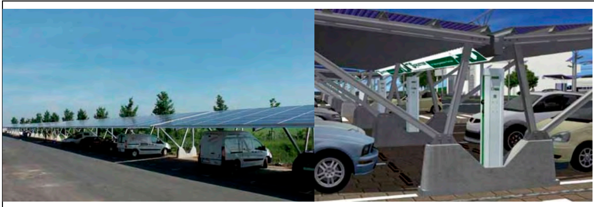
Abbildung 83 a/b – Solarcarports mit integrierter Ladetechnik. Quelle: Schletter.de
