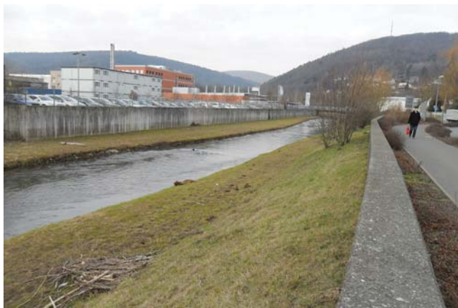
Abbildung 42: Foto, Flutgraben und Bahnhofstraße
