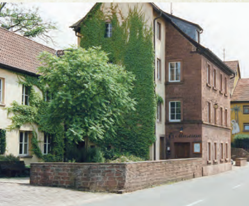
Außenansicht von der Straße
